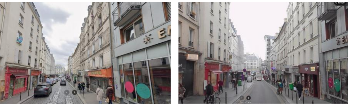
43 rue du Fbg du Temple avant et après travaux (mars 2023 / mars 2025) Source Google maps / street view
